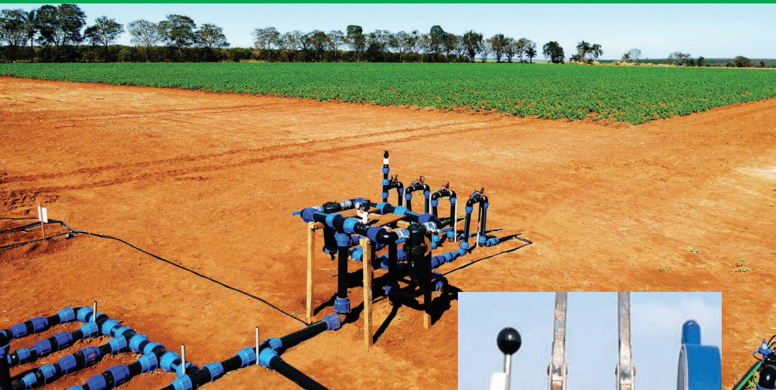
Instalação superficial de tubulação de polietileno com cavaletes de setorização e filtragem também em polietileno.
